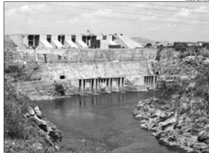
Usina Hidrelétrica de Paulo Afonso, Bahia
